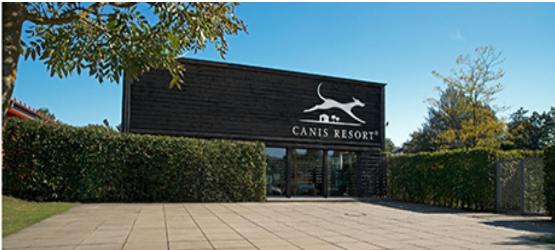
Figure 1. "Canis Resort" (von Meier Architekten)
